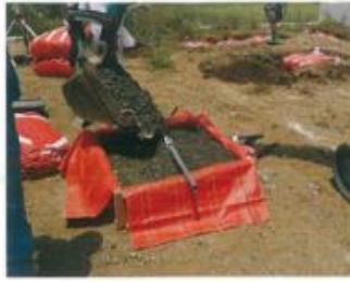
②中詰材料を投入
