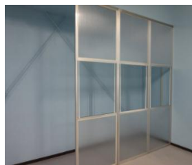
〈シンクウォール設置〉
