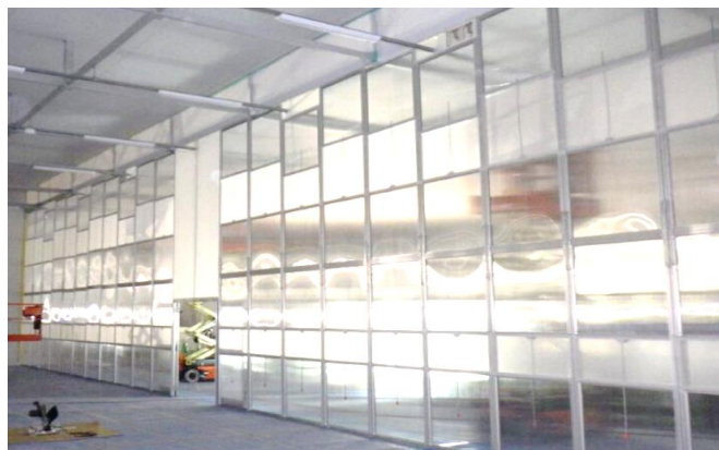
＜半導体工場内シンクウォール施工事例＞
