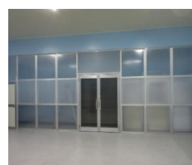
〈シンクウォール設置完了〉
