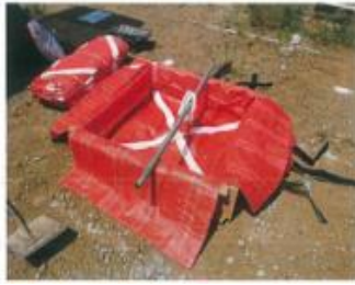
①型枠にD-BOXをセット
