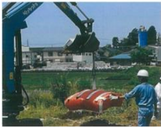
④クレーンで釣り上げ設置
