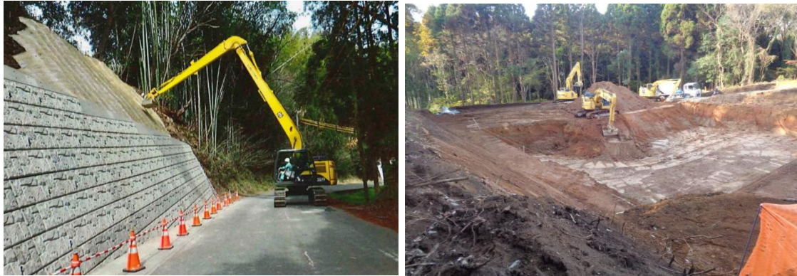
〈出典：前田技建工業ホームページ〉
