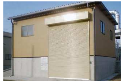
〈アスベスト保管施設〉
