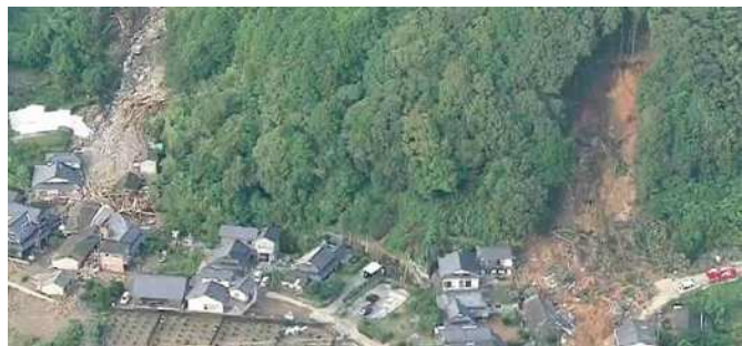
〈芦北町女島小崎地区土砂崩れ 資料：熊本県 HP より抜
